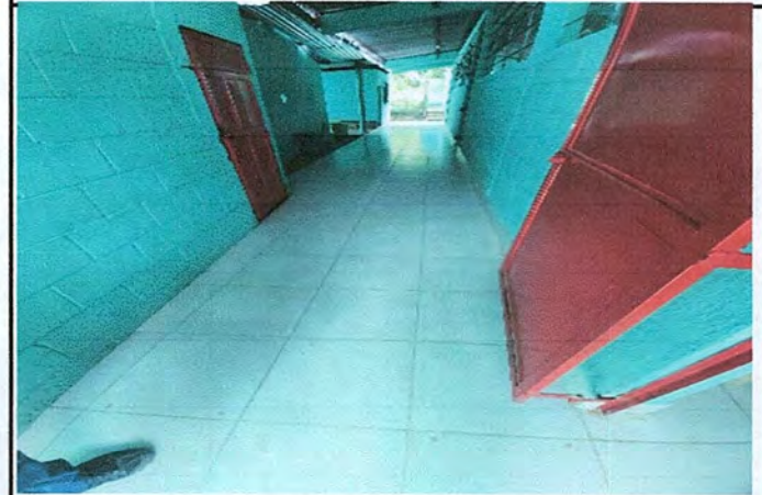
Foto 4: MEJORAMIENTO DE PISO
