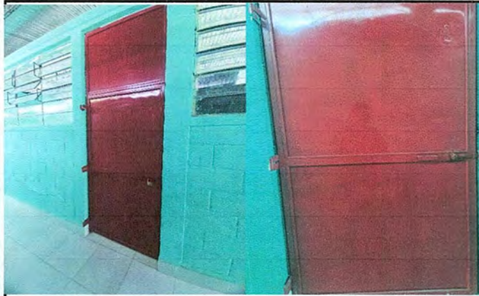
Foto 1: MEJORAMIENTO DE PUERTAS
